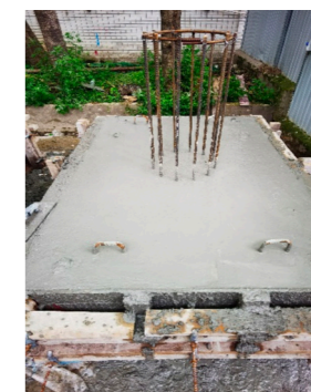
(b) 槽口对应预埋钢筋
