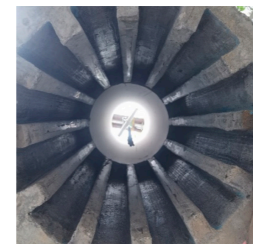
(a) 装配式空心墩内部锯齿槽
