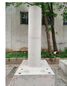
(d) 现浇墩台浇筑成型
