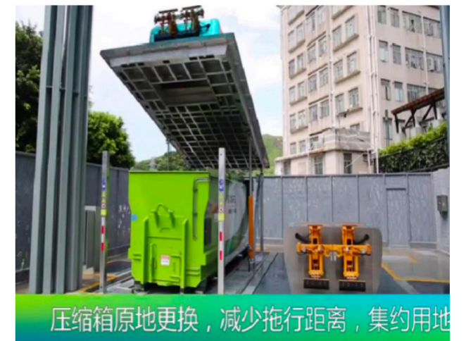
图12 更换空压缩箱放回地埋平台
