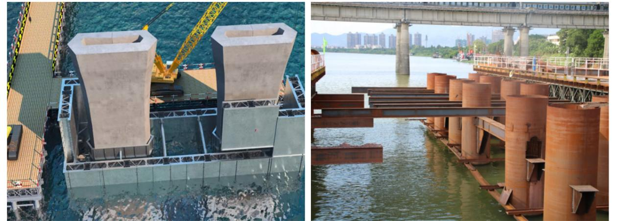
3. 提出了可自浮实现快周转使用的双壁钢围堰施工方法，改进了钢围堰内部连接工艺，研发了钢围堰抽水增浮技术。
