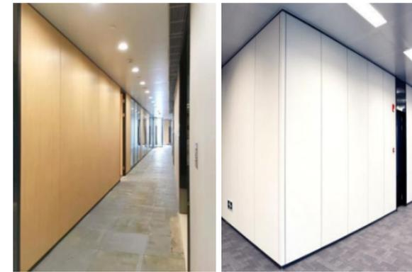
图11 装配式隔墙墙面拼装效果
