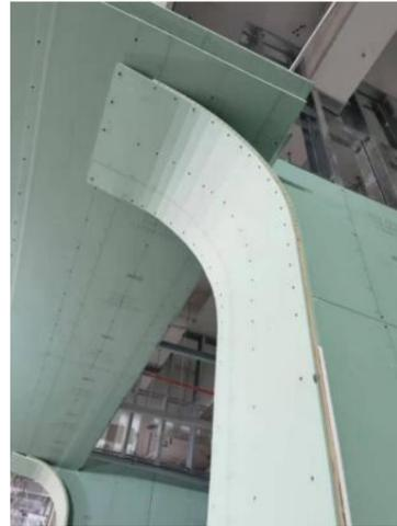
图2 传统施工工艺弧面造型
