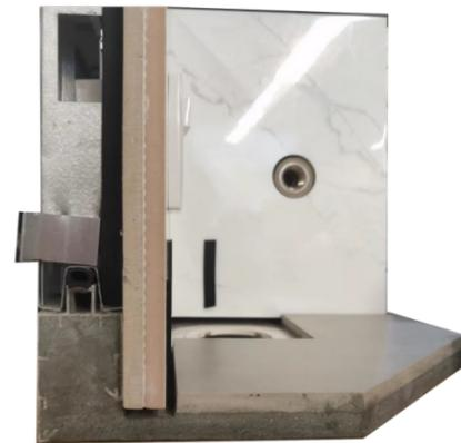
图8 卫生间部品墙面地面防水方式
