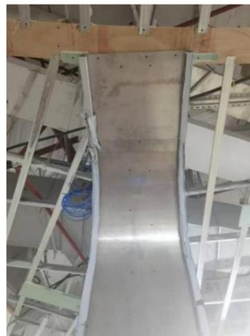
图3 装配式部品生产弧面造型
