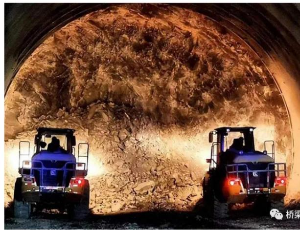
隧道进口端施工布置为左、中、右三个洞口同时掘进，中洞为服务隧道采用TBM硬岩盾构机掘进，为左右双主洞开辟辅助工作面，实现“长隧短打”，有效节约施工工期。据悉，该技术在国内外高速公路隧道施工中尚属首次应用。
